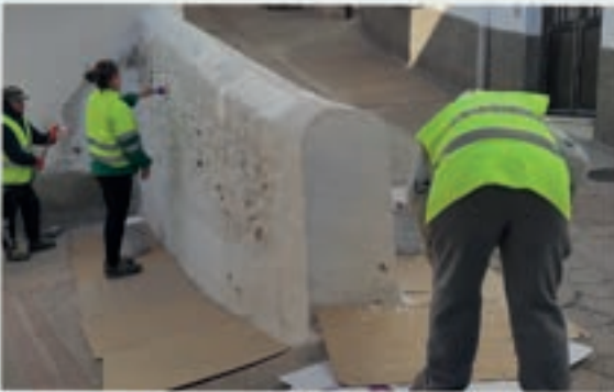
Pintura de muretes
