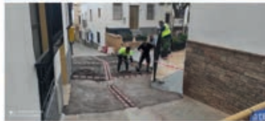
Tramo calle Horno
